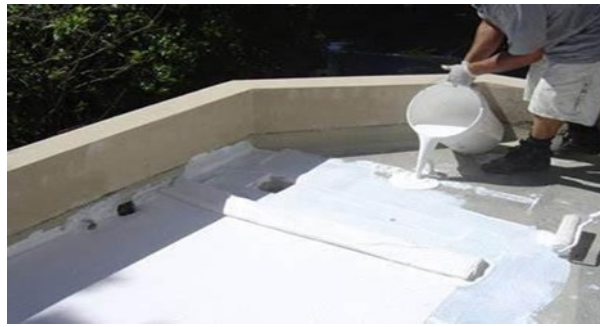
चित्र 1.3— तरल जलरोधन झिल्ली
