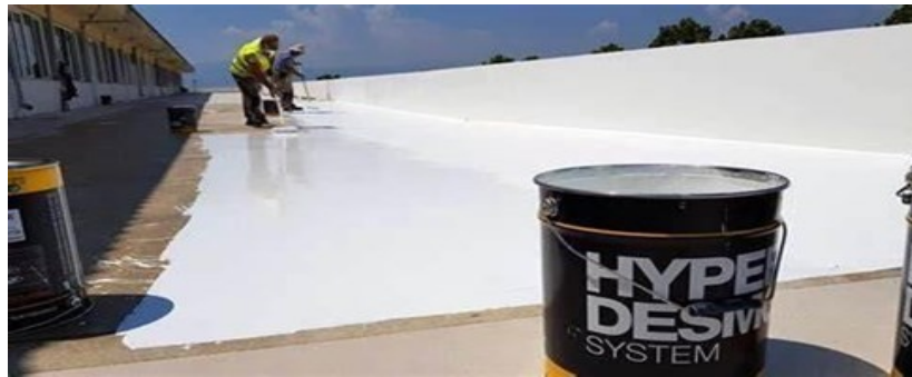
चित्र 1.5— पॉलीयूरेथेन तरल झिल्ली
